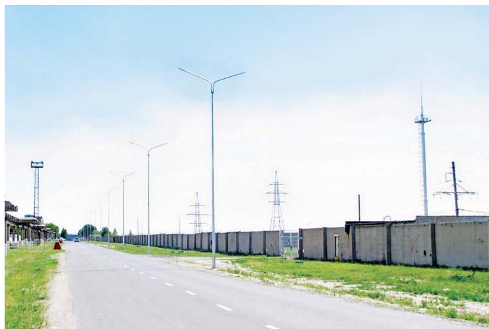
Уличное освещение после замены на светодиодные светильники
