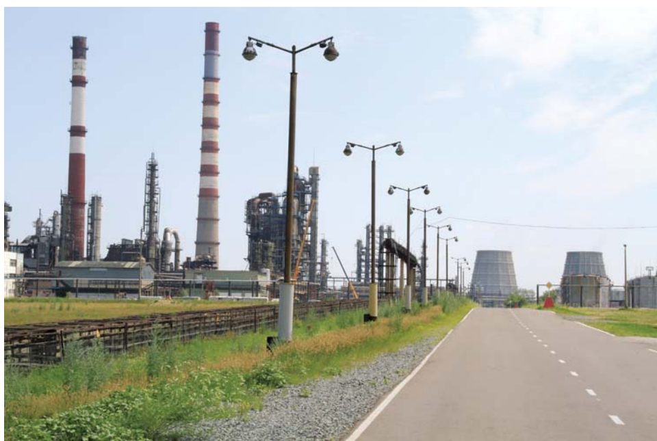
Лампы накаливания до замены светодиодными светильниками
