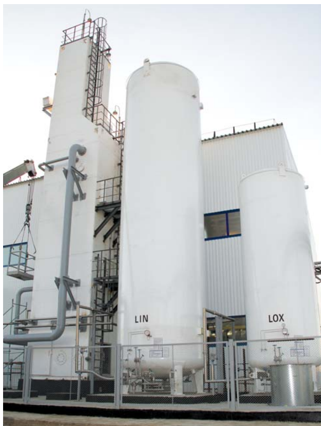
Криогенные емкости для хранения жидкого азота на 50 м³ и жидкого кислорода на 10 м³
