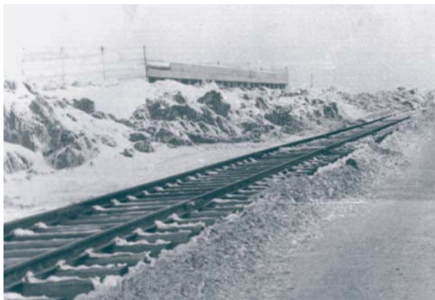
Площадка под строительство эстакад налива
