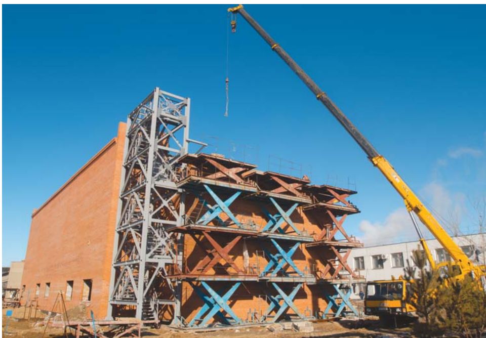
Будущая воздушная компрессорная станция
