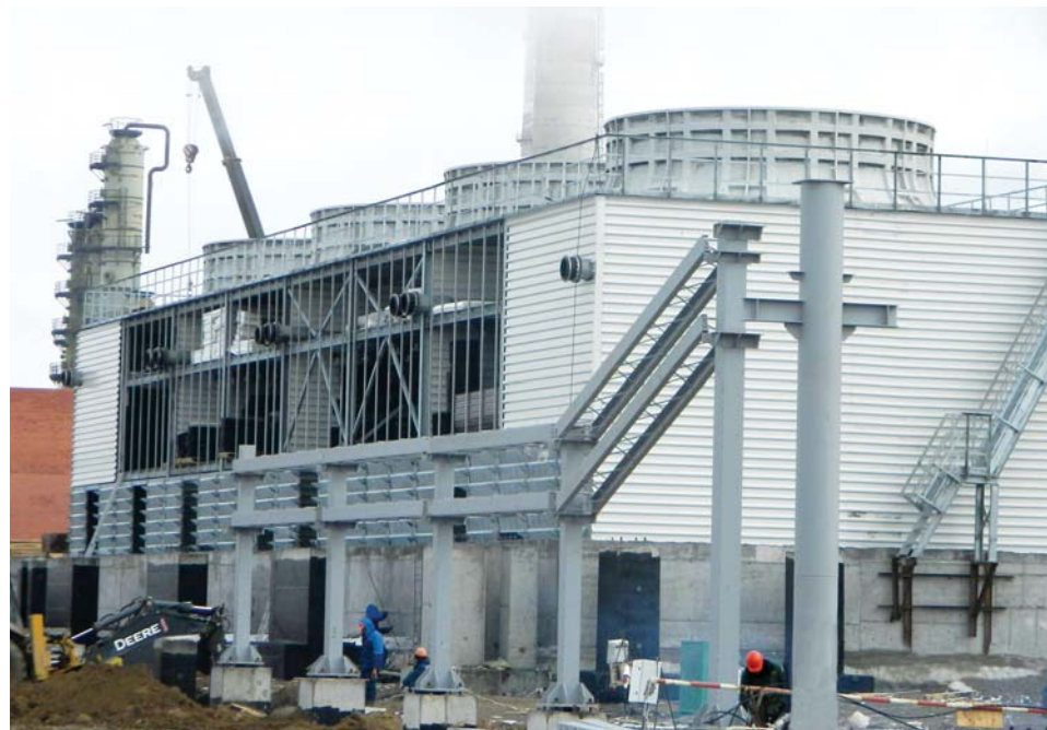
Строящаяся система охлаждающей воды и градирни
