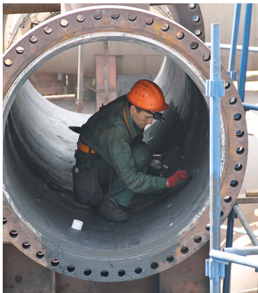
Ремонт корпуса теплообменника Т-101/1 на КТ
