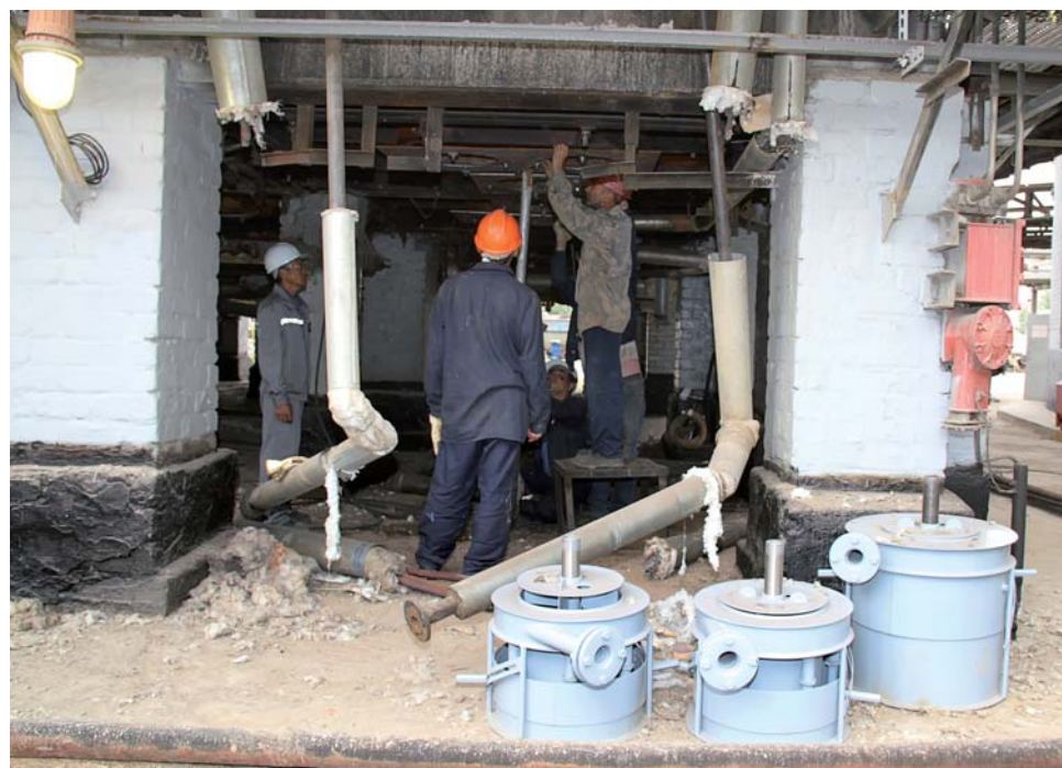
Монтаж новой форсунки печи П-101/5-8 секции на ЛК, подрядчик ТОО «Нефте- строймонтаж»
