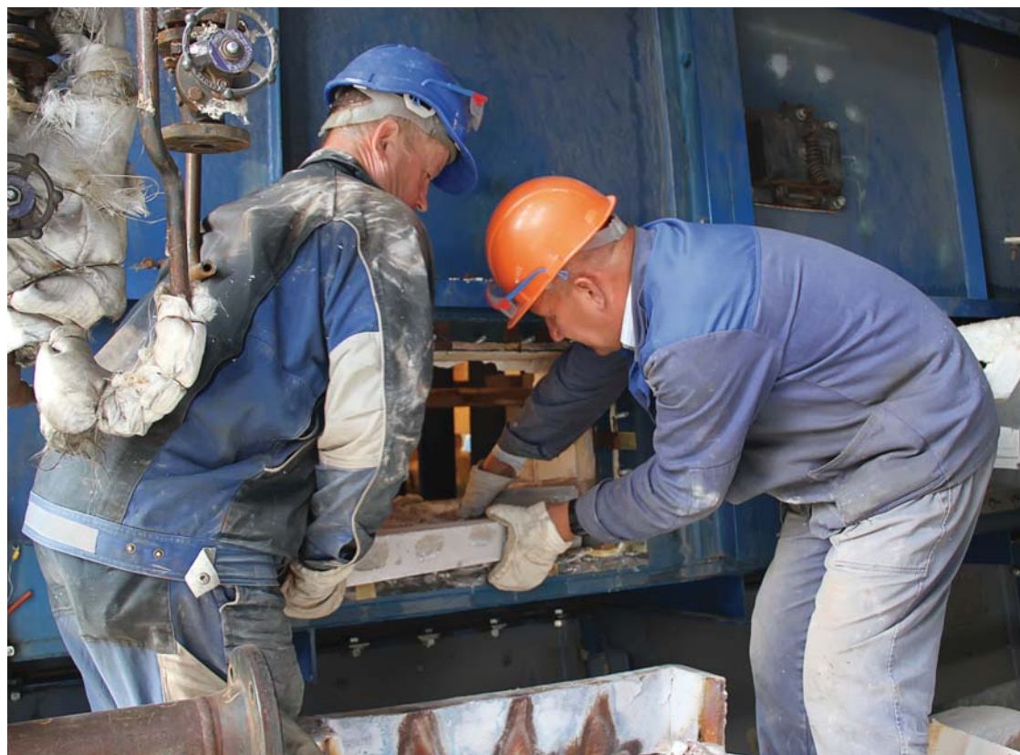
Замена горелочных камней на печи парового риформинга В-201 на УПВ
