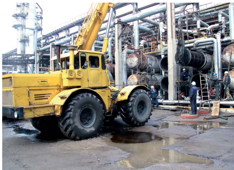
Демонтаж трубного пучка Т-113 на ЛК, подрядчик ТОО «РМУ»
