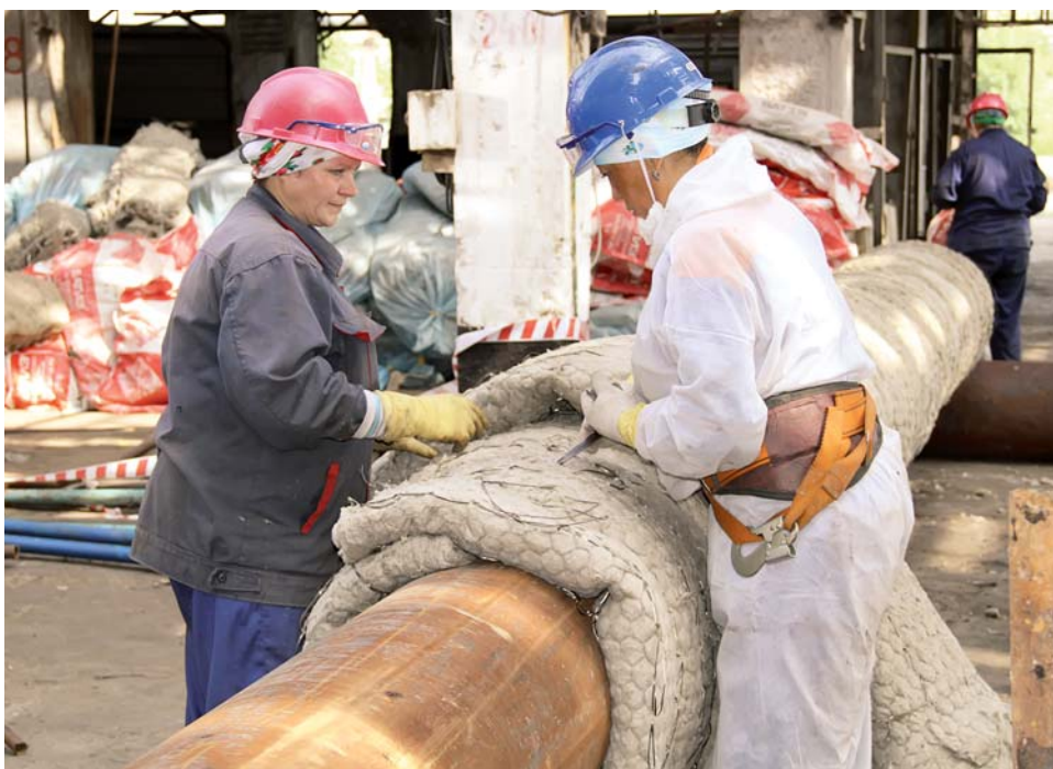
Теплоизоляция трубопроводов колонны К-601/1 на КТ
