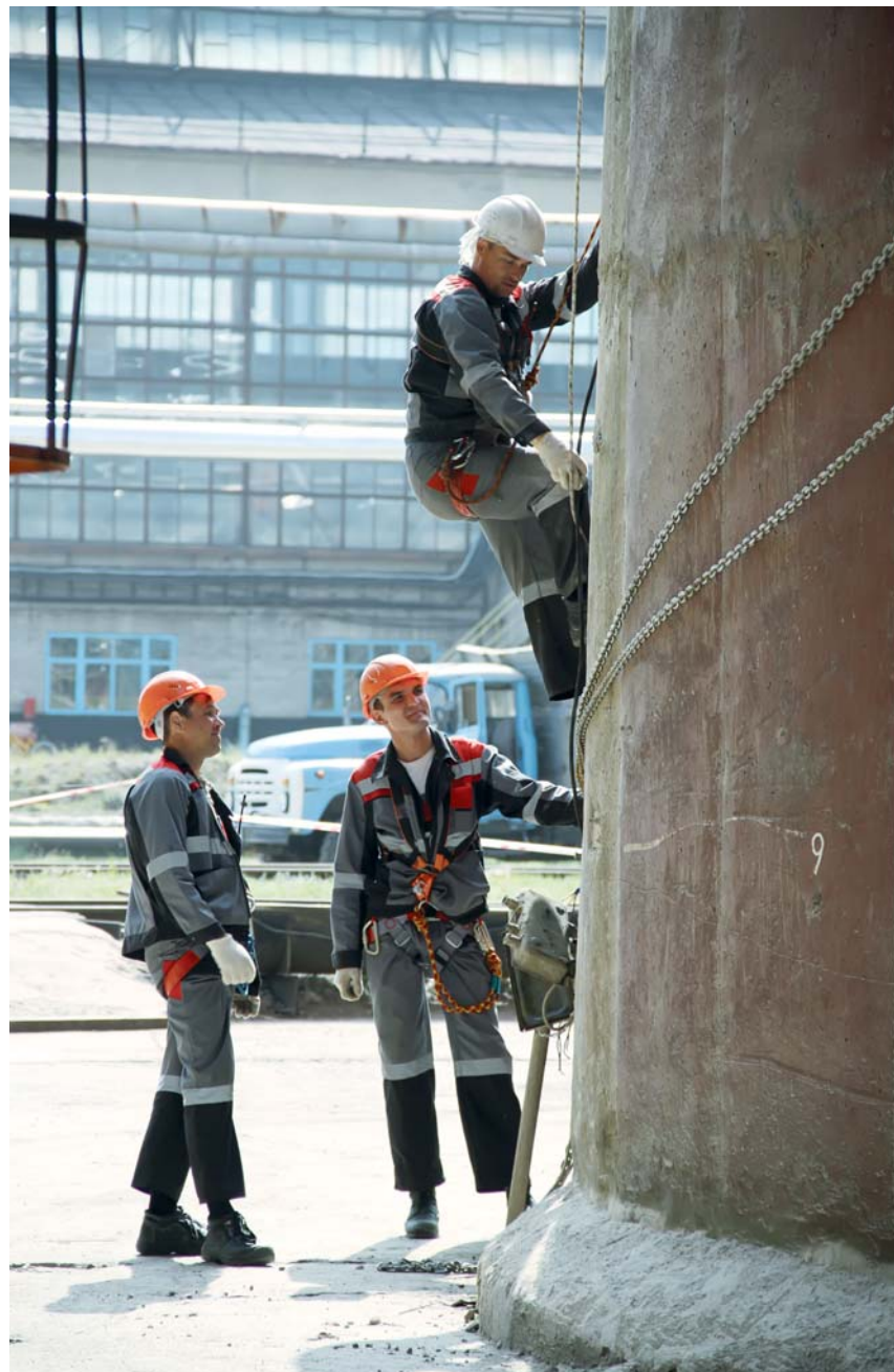
Ремонт дымовой трубы КТ-1, подрядная организация CRS – Проф
