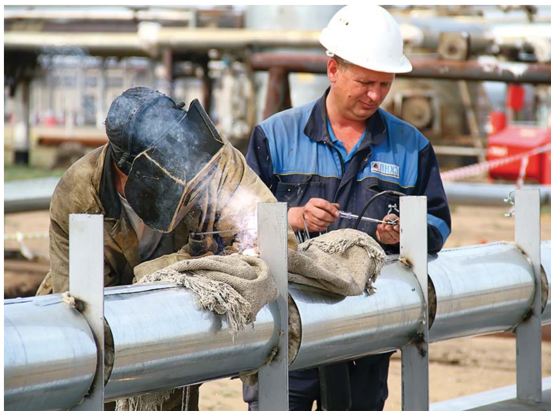
Монтаж приспособлений для термопара факельного ствола на АГУ
