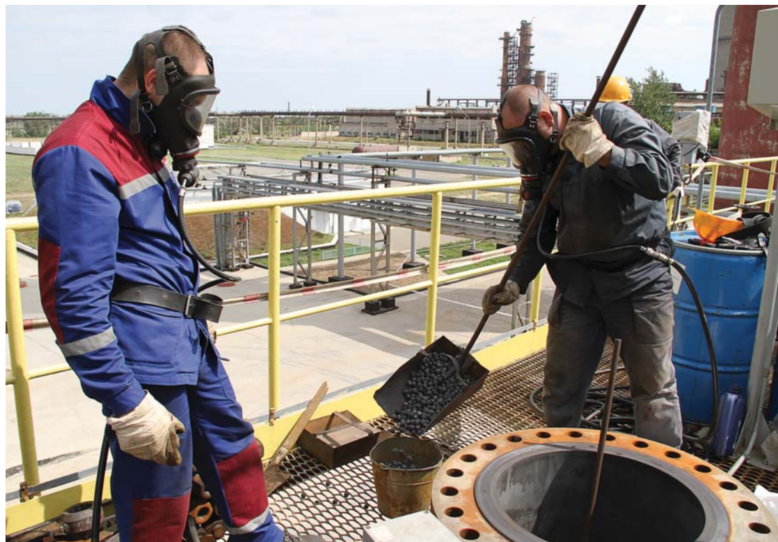
Выгрузка керамических шаров из реактора R-301 на УПВ
