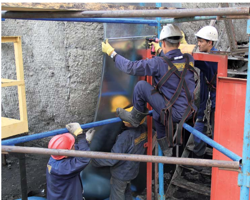
Замена теплоизоляции ЭД-102 на ЛК
