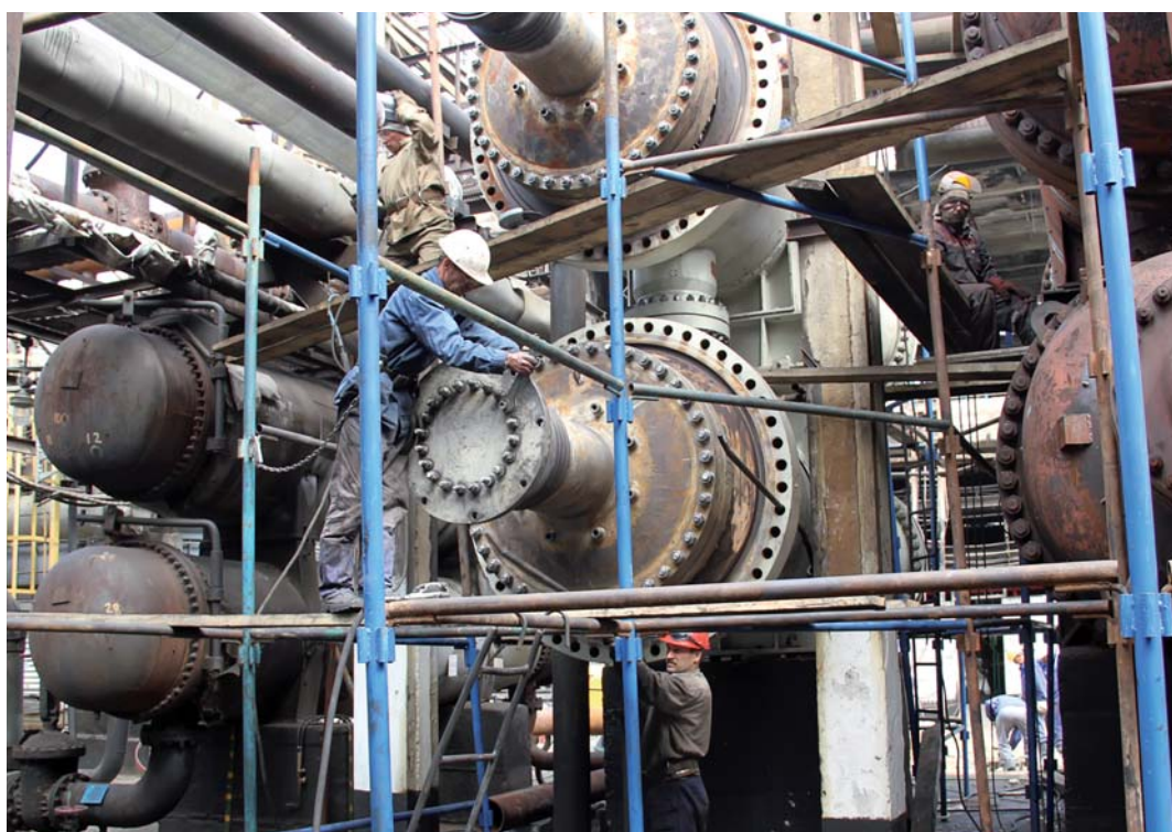
Монтаж теплообменника Т101/1-6 на КТ
