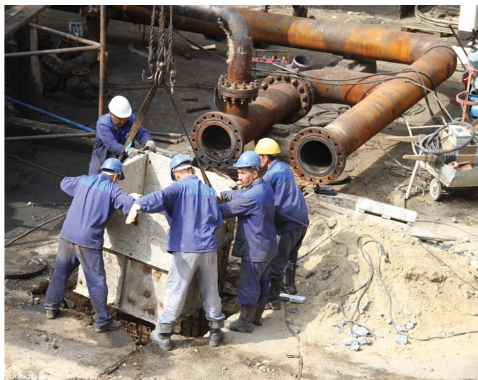
Заливка фундамента под опоры трубопроводов Т-101-х на КТ
