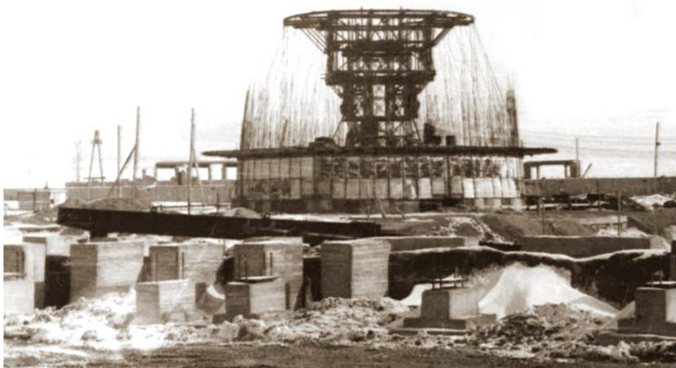
1973 год. Строительство дымовой трубы ЛК-6У
