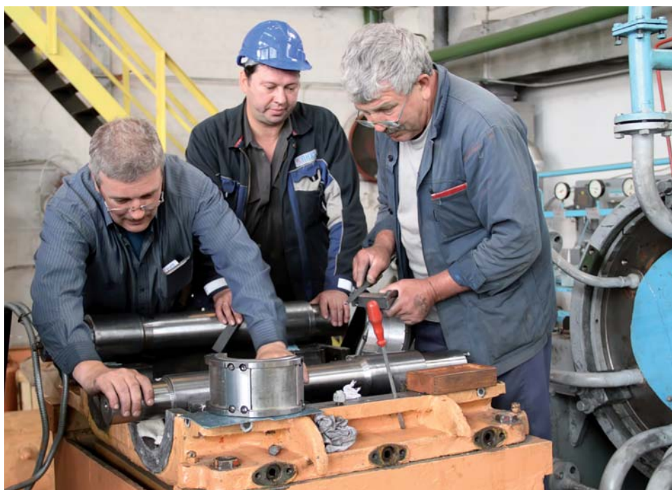
Модернизация компрессора ЦК-301 на ЛК
