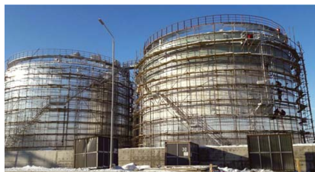
Работы по теплоизоляции резервуаров кислых стоков
