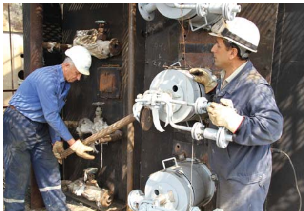
Замена форсунок печи П-203/3. ТОО «Нефтестроймонтаж» г. Шымкент
