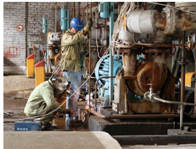
Ремонтные работы на Н-203. ТОО «РМУ» г.Шымкент
