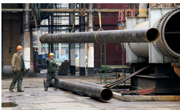
Замена трубопровода (оборотная вода 1 системы)
