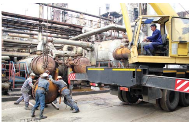
Демонтаж теплообменников Т-201 и Т-202. ТОО «РМУ» г. Шымкент
