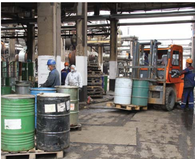
Выгрузка катализатора из реактора Р-101/2
