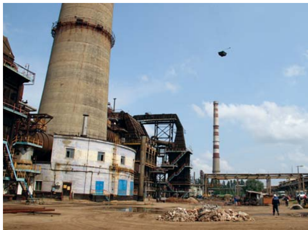
Покраска дымовой трубы. ТОО «GRS ПРОФ» г.Усть-Каменогорск
