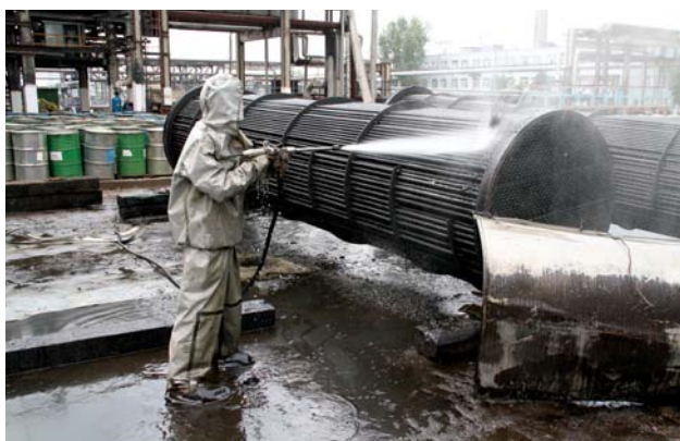
Чистка пучков теплообменников
