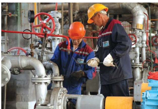
Установка заглушек на Н-425. Слева-направо: оператор Байдарханов Н.А., машинист Абилов С.И.
