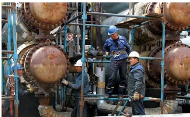
Демонтаж теплообменников Т-201 и Т-202. ТОО «РМУ» г. Шымкент
