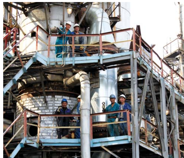
Демонтаж кипятильника Т-408. ТОО «РМУ» г.Шымкент
