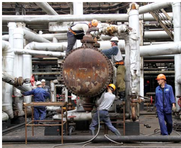
Демонтаж распределителя Т-313
