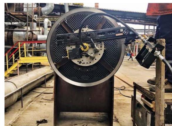
Проточку уплотнительной поверхности на трубном пучке Т 302 на ТОО «ПНХЗ» производит подрядная организация ТОО Сервисная Компания «ИНТРА»
