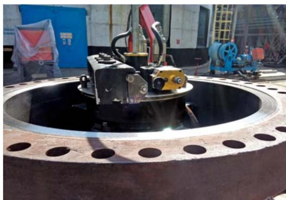
Проточку уплотнительной поверхности теплообменника Т 302 на ТОО «ПНХЗ» производит подрядная организация ТОО Сервисная Компания «ИНТРА»
