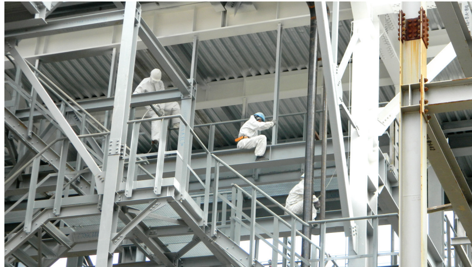
Работники компании «Access Solutions» (г. Алматы) наносят огнезащитное покрытие на металлоконструкции установки изомеризации
