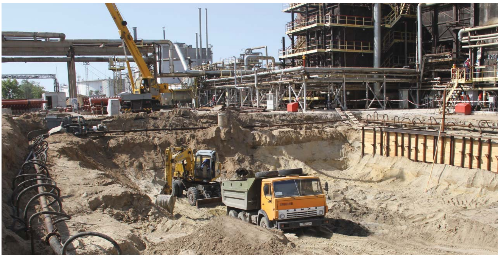
Сотрудники ТОО «Тотал Сервис» производят разработку котлована под будущий фундамент реакторов гидроочистки дизельного топлива
