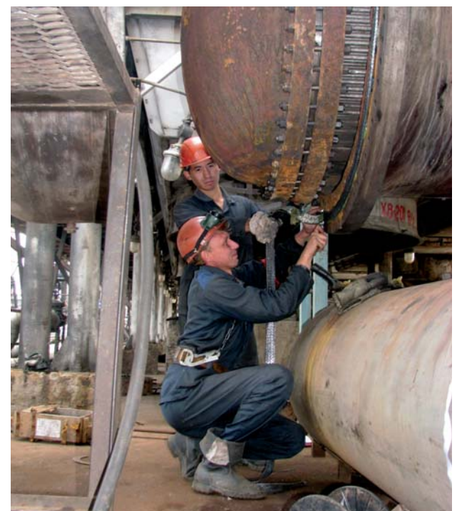
Ремонт теплообменной аппаратуры С-200
