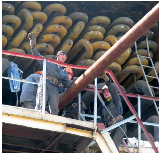
Замена трубопровода в печи П-102
