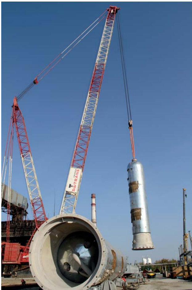
Монтаж новых реакторов. Исполнитель: генподрядчик — Rominserv S.R.L.
