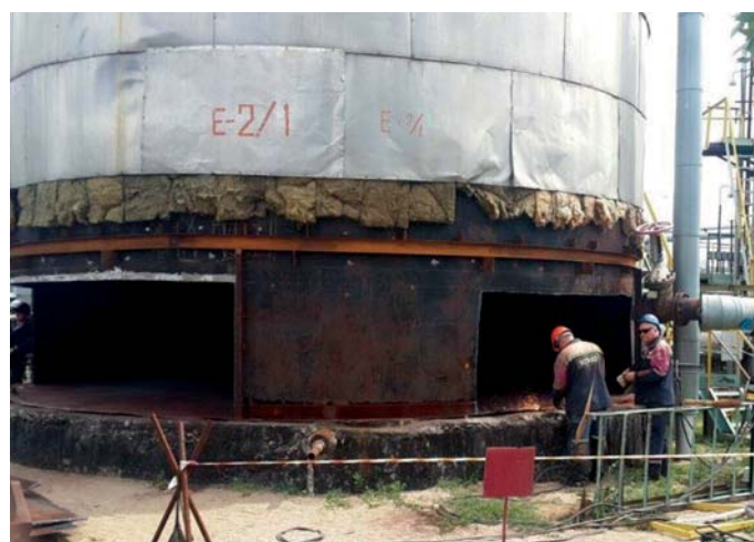
Ремонт ёмкости Е-2/1 в цехе №16. Исполнитель: РСМУ ТОО «ПНХЗ»
