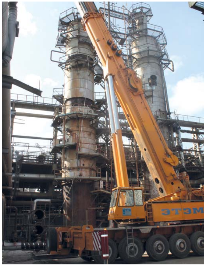
Демонтаж старой колонны К-202. Исполнитель: ТОО «ЭТЭМ»
