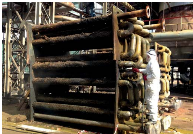
Чистка пакетов конвекции печей П-301/1 и П-301/2. Исполнитель: ТОО «НСМ»
