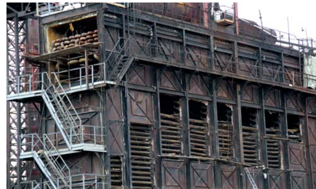
Замена продуктового змеевика зоны конвекции печи П-601/2. Исполнитель: РСМУ ТОО «ПНХЗ».
