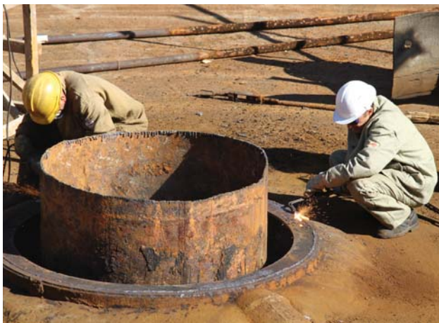
Замена корпуса илоотстойника в цехе №8
