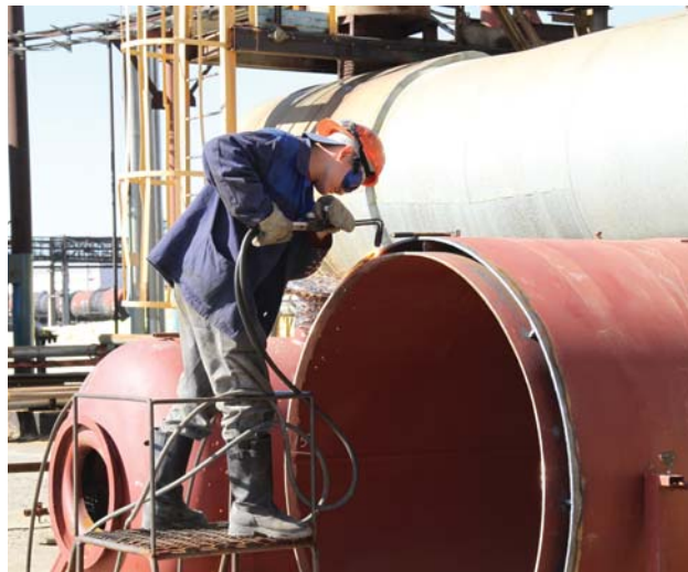
Подготовка части котла к монтажу, УПС
