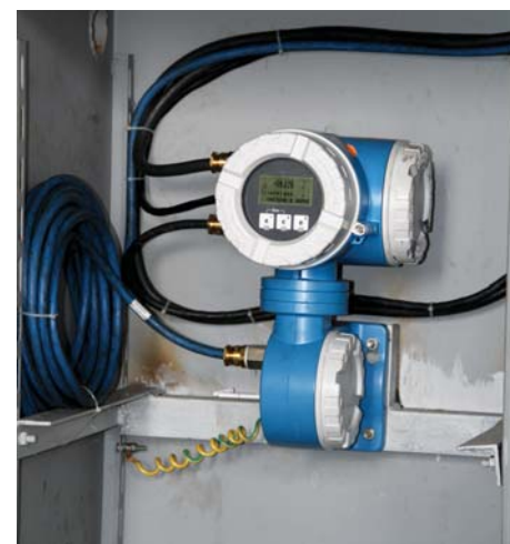
Конвертер массового расходомера PROMASS. Установлен на КТ-1.
