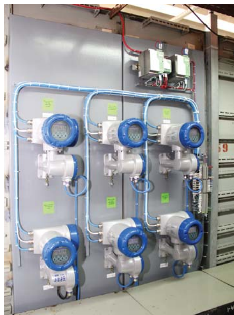
Конвертер MFC 300 массовых расходомеров OPTIMASS. Установлен на ЛК-6У.
