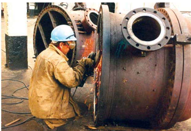
2003 год. Капремонт на КТ-1. Монтажник Жибров В.Н.
