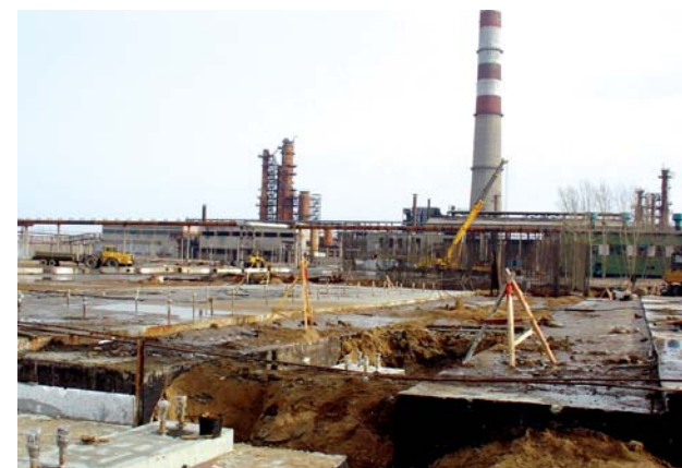
2006 год. Строительство новой установки водорода
