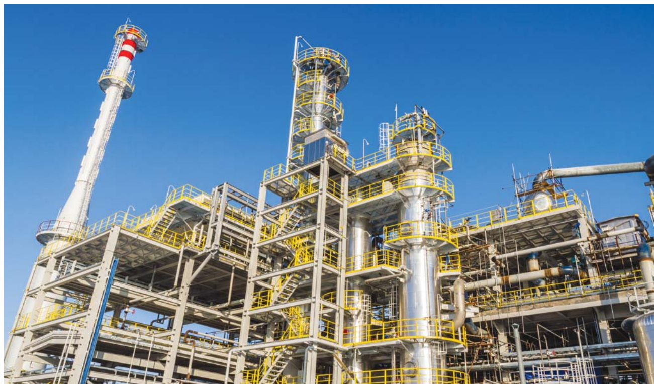
Строящаяся комбинированная установка производства серы
