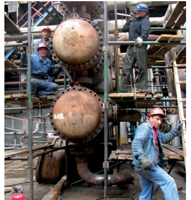
ТОО «РМУ» ремонт теплообменника Т-201, Т-202 секции 200
