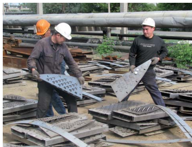
Монтаж новых клапанных тарелок К-104
