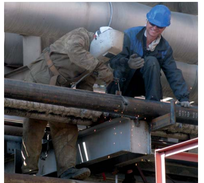
Сварочная бригада «РМУ» ведет монтаж трубопровода вывода фракции 180-300 в товарные парки
