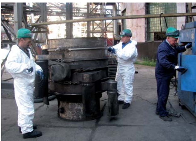
ООО «Оргнефтехим» производит выгрузку катализатора из реактора Р-301 С-300
