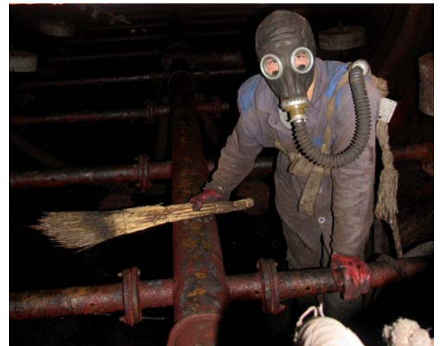
Чистка от отложений электродегидратора ЭД-107 С-300
