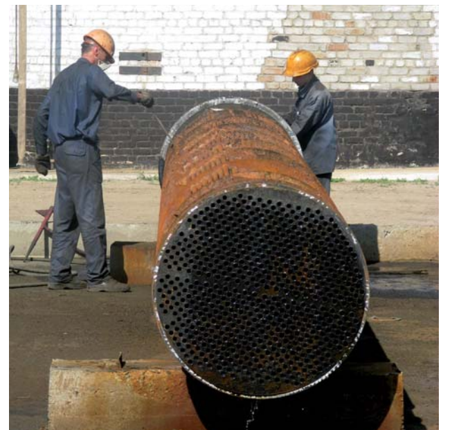
Операторы С-100 ведут чистку пучков теплообменных аппаратов
