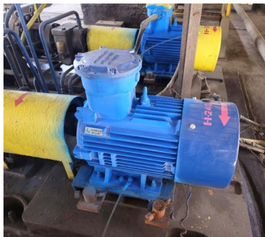
ПГПН, С-200, Н-240/1, Н-240/Р Замена взрывозащищенных электродвигателей 30 кВт
