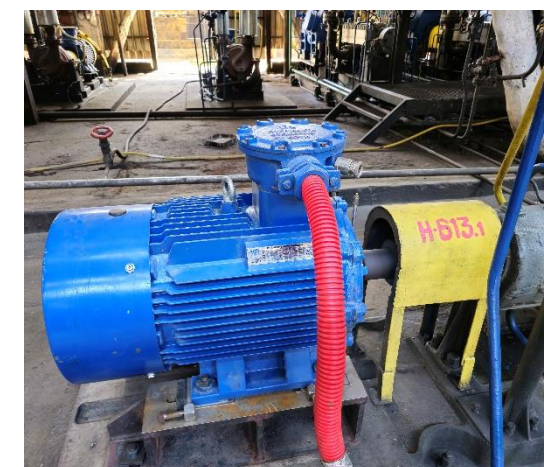
ПГПН, С-001, Н-613/1 Замена взрывозащищенного электродвигателя 55 кВт
