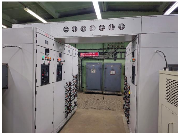
РУ-0,4кВ ТП-202, очистные сооружения, цех ВК Замена распределительного устройства
