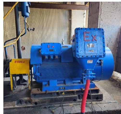
ПГПН, С-001, Н-606/2 Замена взрывозащищенного электродвигателя 315 кВт
