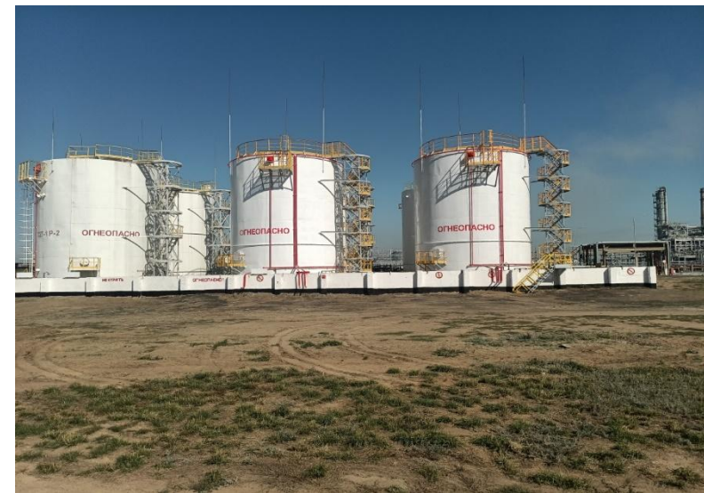
Капитальный ремонт резервуаров поз.Р-1 и Р-2 парк 27-5, завершен участок АССБ, производство светлых нефтепродуктов
