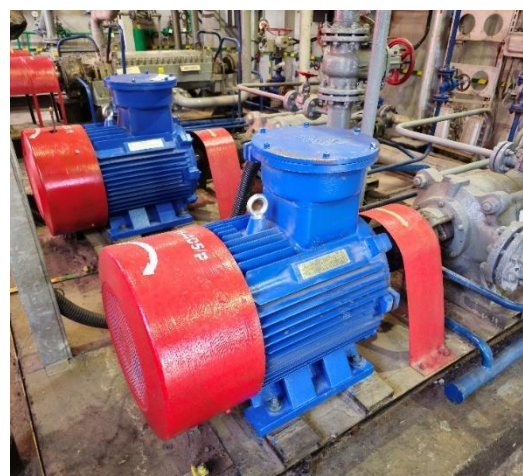
ПГПН, С-400, Н-405/Р Замена взрывозащищенного электродвигателя 75 кВт
