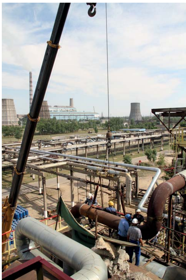
Ремонт линии 206/3, «РМУ» (г. Шымкент)
