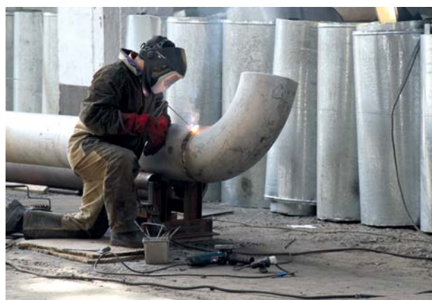
Монтаж линии №103/1 от реактора Р-101/1 до теплообменника Т-101/1, цех №15
