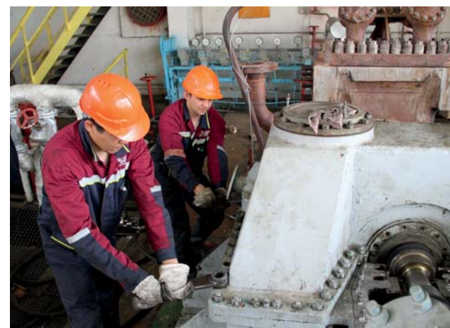
Капитальный ремонт паровой турбины на ЦК-201 силами цеха №10
