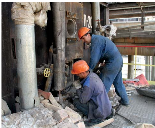
Сборка форсунок печи П-203/2. Операторы С-200 Д. Затримайло и Г. Сафуллин
