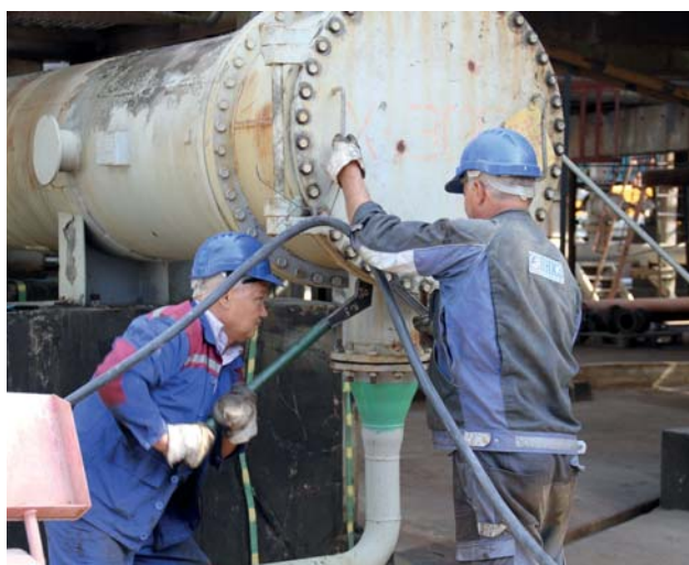
Сборка холодильника Х-306 на С-300. Операторы секции К. Джусупов и П. Зяблицев
