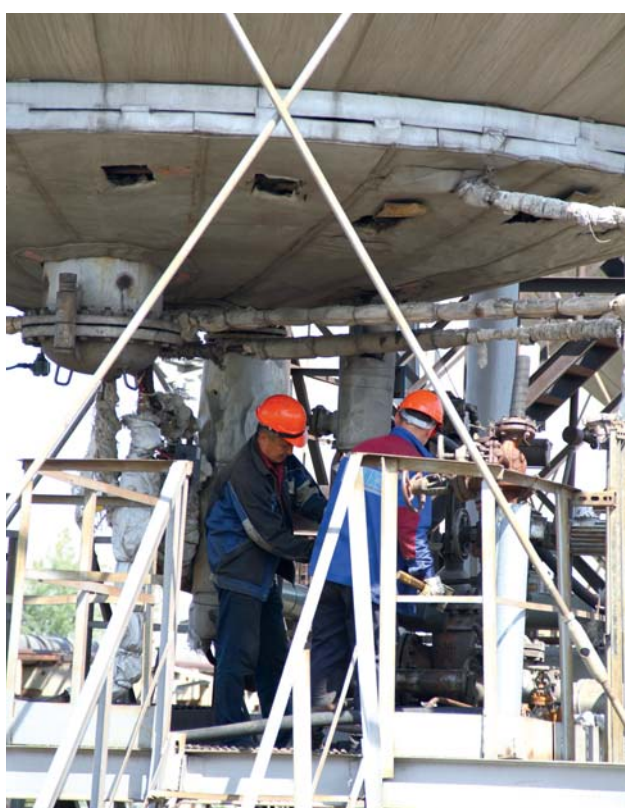
Работы по снятию заглушки на емкости Есф-4 парка 31-1/2, ПСГ. Оператор М. Тукунов и машинист М. Коламеев, цех №2
