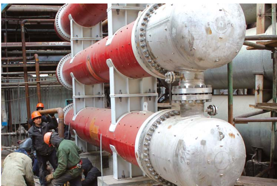
КГПН, секция 200 (каталитический риформинг). Изготовление узлов трубопроводов обвязки теплообменников Т-202 А/1, 2, 3. Исполнитель работ – ТОО «МегаСтройПлюс», субподрядчик – ТОО «ПавлодарСпецМонтаж»
