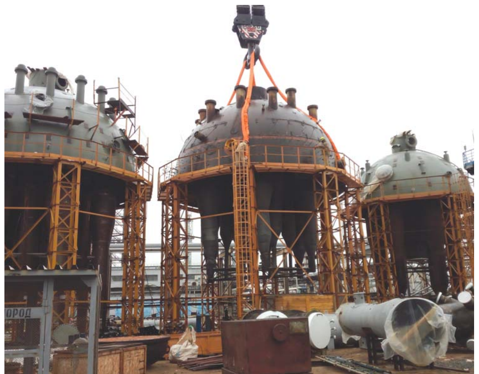
КГПН, секция 200 (каталитический крекинг и ректификация сернистого сырья). Демонтаж верхнего днища (купола) регенератора Р-202. Исполнитель работ – ОАО «Омское монтажное управление специализированное №1» («ОМУС-1», Россия)
