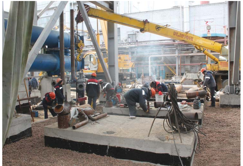
КППН. Изготовление узлов трубопроводов обвязки оборудования. Исполнитель работ – ТОО «МегаСтройПлюс», субподрядчик – ТОО «ПавлодарСпецМонтаж»
