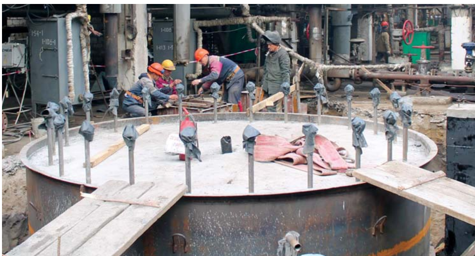
КГПН, секция 100 (установка гидроочистки вакуумного газойля). Монтаж опалубки под заливку фундамента опор трубопроводов обвязки емкости Е-506, титул В100К. Исполнитель работ – ТОО «МегаСтройПлюс»
