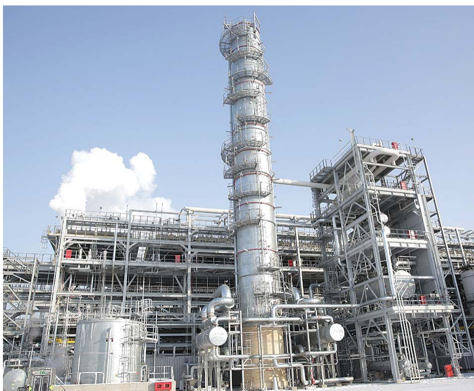
Установка изомеризации и сплиттера нафты
